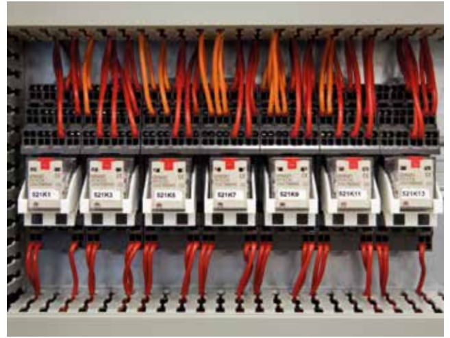
Daha küçük olmaları ve birbirleriyle daha iyi eşleşmeleri sayesinde daha kolay monte edilebiliyorlar
