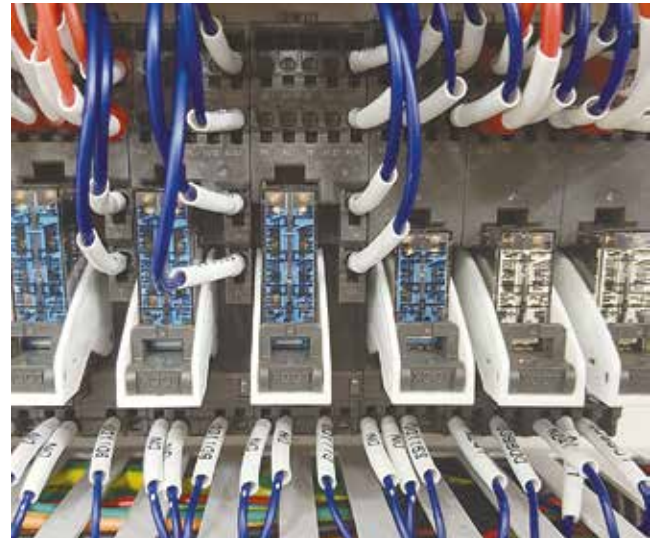
80% komponentów wyposażono w zaciski Push-In Plus.
