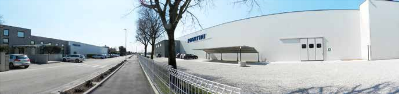
For å oppnå bedre drift utvidet Martini i 2017 produksjonsanlegget med 2000 m2.
